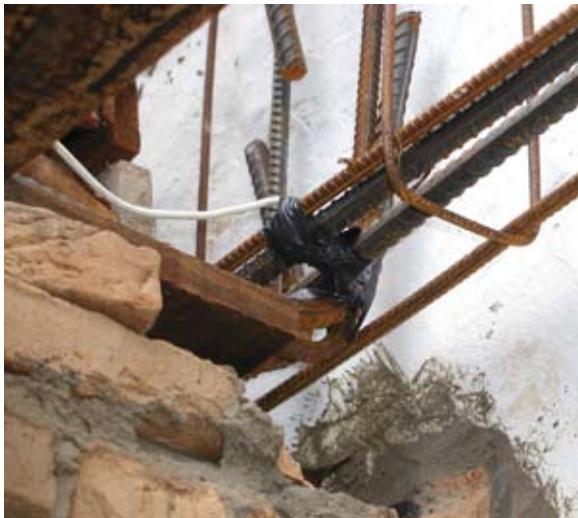
Fotografía de la conexión a tierra de la armadura metálica.
